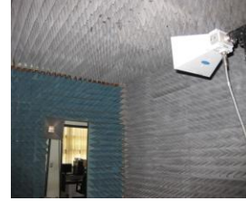
Gambar 2.8 Pemasangan di ruang Chamber
